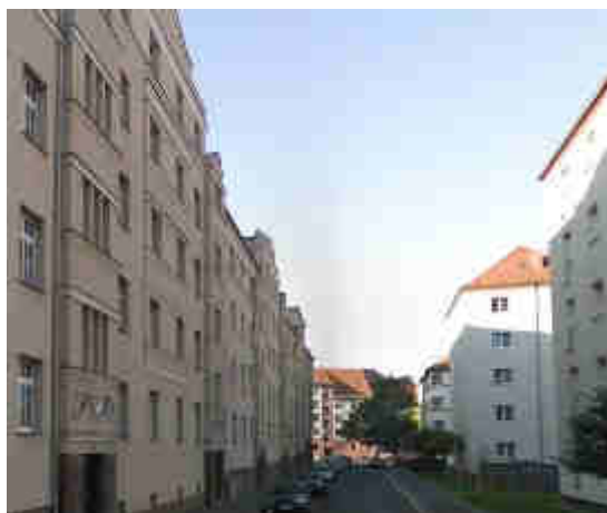
Foto 2: Stichprobengebiete Reudnitz-Thonberg und Anger-Crottendorf / Sellerhausen [(BS 2a) Mehrfamilienhäuser, 1.100 l MGB]
